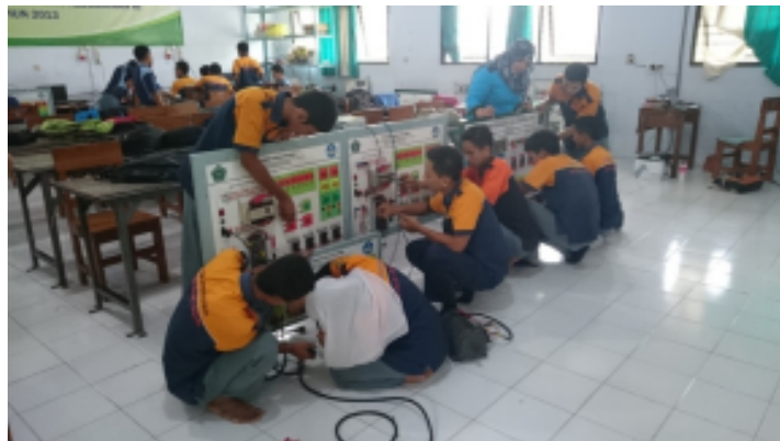
Gambar 4.8 Praktik Instalasi motor di ruang bengkel SMK Islam 1 Blitar 32
